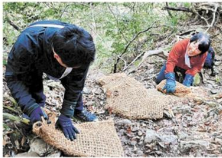
土が削れた箇所に土のうを積み参加者ら
